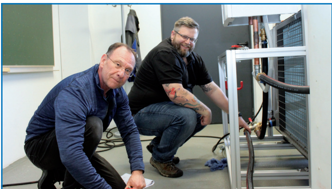
W. Sarcev und S. Bellm (v. l.) bei der Vorbereitung einer WP-Messung
