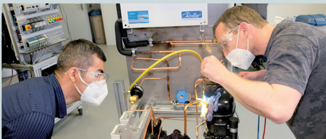
Praxiskurs-Teilnehmer errichten an vier Nachmittagen eine Kälteanlage
